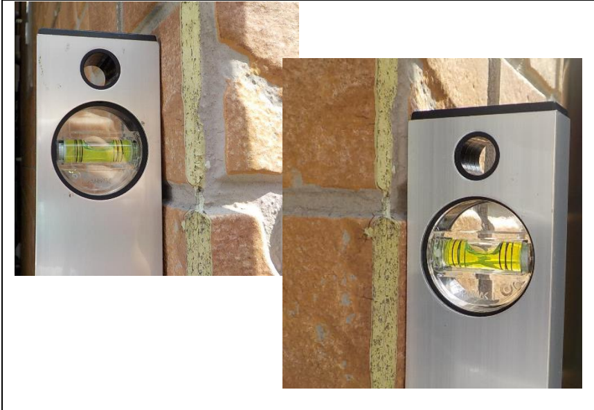
⑧外壁の傾斜計測 傾斜は有りません=健全です 西面・北面の角計測
